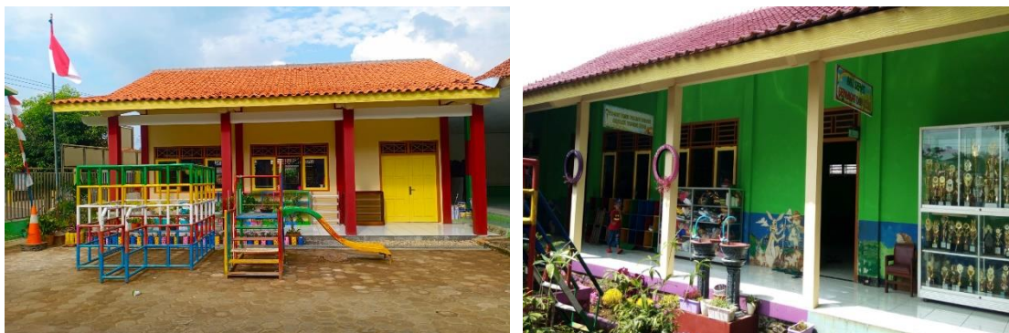
Gambar 3.2 Hasil Rehabilitasi Ruang Kelas TK Negeri Pembina Limpung
